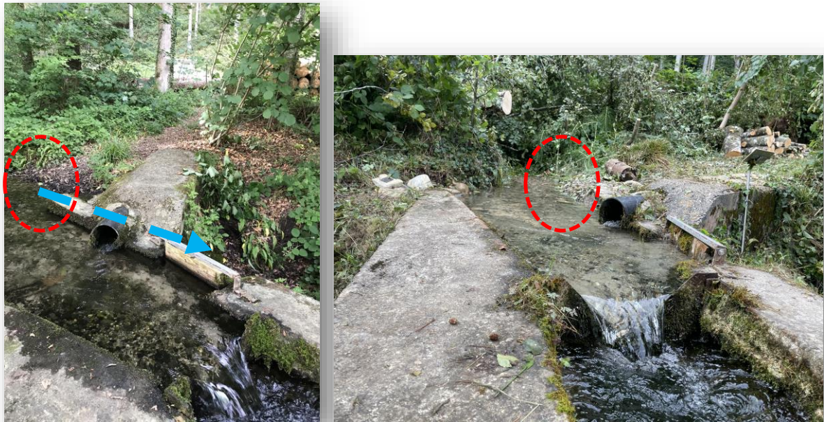
Einlaufbauwerk abgedichtet!
