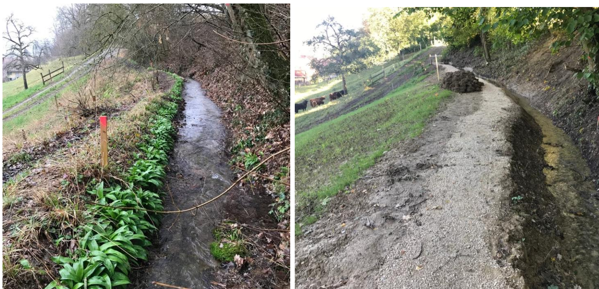
Abbildung 9 - Strecke 660m: Situation vorher und nachher
