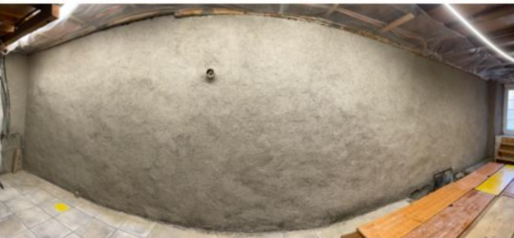
14.02.2025 Ostwand – fertig > mit einem Besen verwaschen → TOPJOB!
