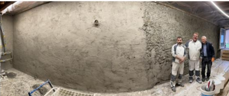
13.02.2025 Ostwand – 2. Lage fertig mit Fixit 206 linke Seite
