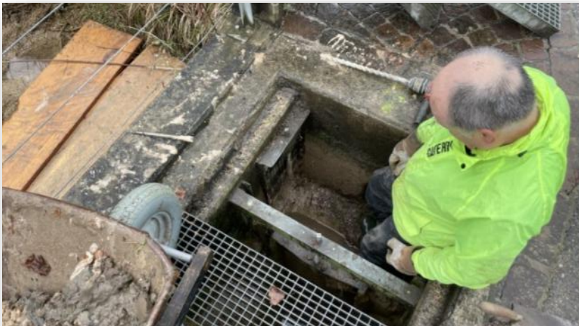
Eine Herausforderung die Engstelle, verursacht durch Verkalkung, im Bereich des Weiher-einlaufes zu eliminieren.
