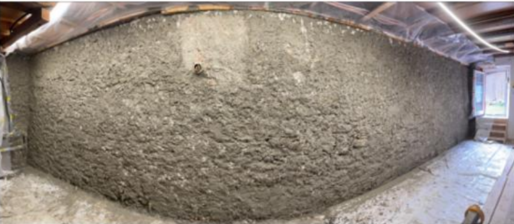
29.01.2025 Ostwand – 1. Lage fertig mit Fixit 211
