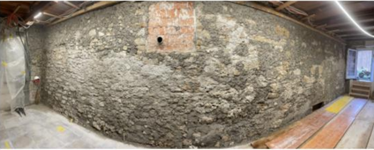
11.12.2024 Ostwand – 1. Lage fertig mit Fixit 206
